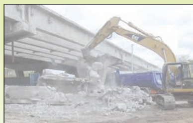
■ Guide matériaux de démolition
