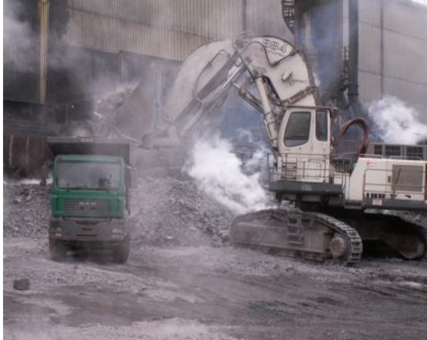
Refroidissement lent à l'air en fosse du LAC de Dillingen
